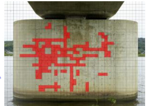
AIを用いた自動検出による点検
