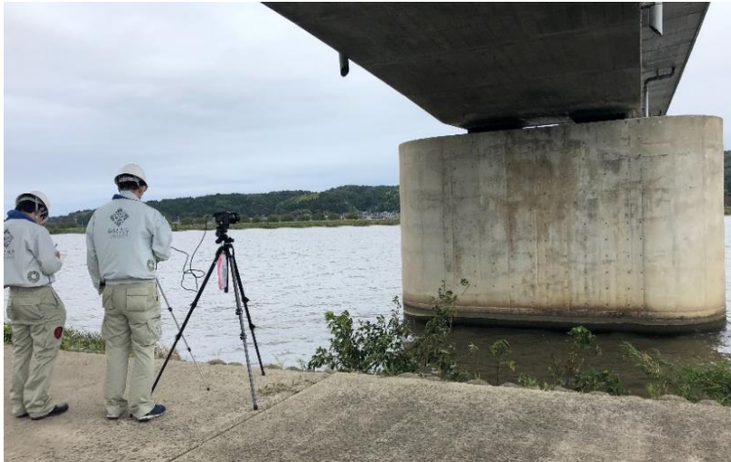
橋梁点検部位の写真撮影
